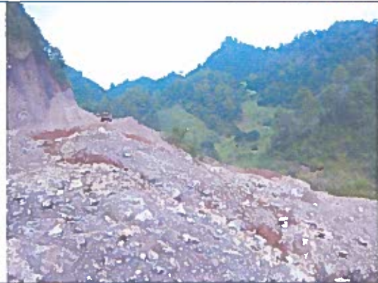
Figura N° 1.2 Deslizamientos, caída de bloques y reptación del suelo
