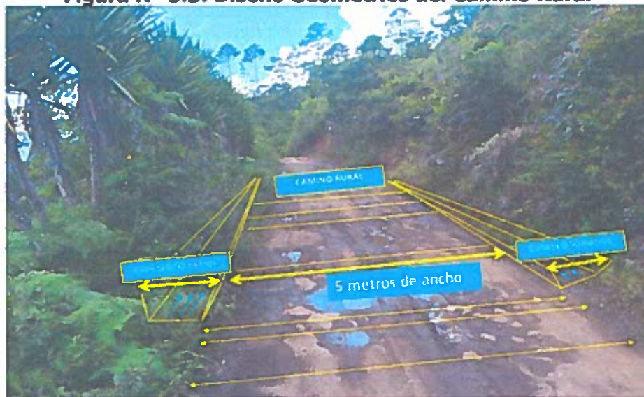
Figura N° 5.3: Diseño Geométrico del Camino Rural
