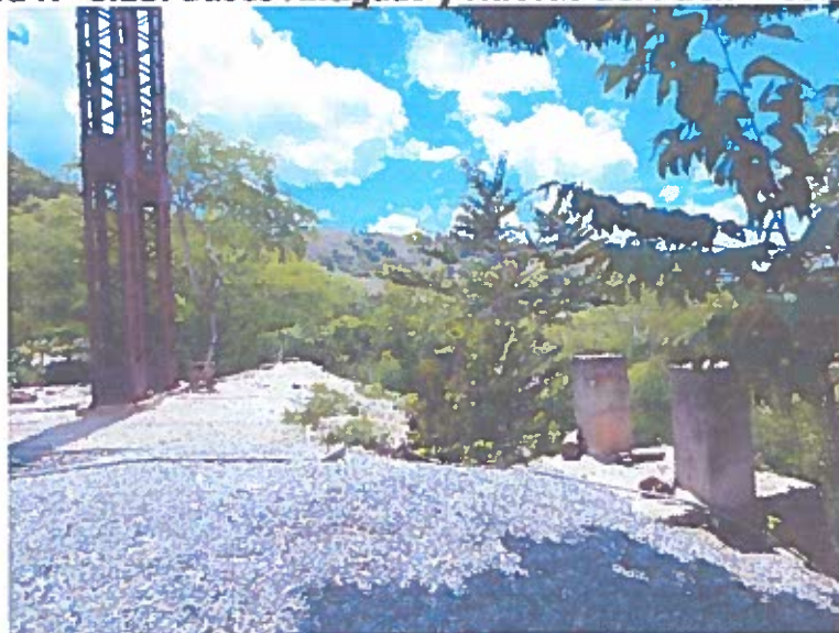
Figura N° 8.13: Bases Antiguas y Nuevas del Puente Colgante.
