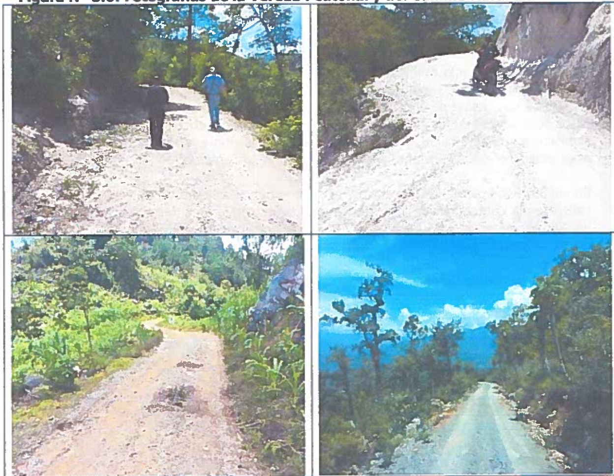
Figura N° 5.6: Fotografías de la Vereda Peatonal y del Camino Rural Existente
